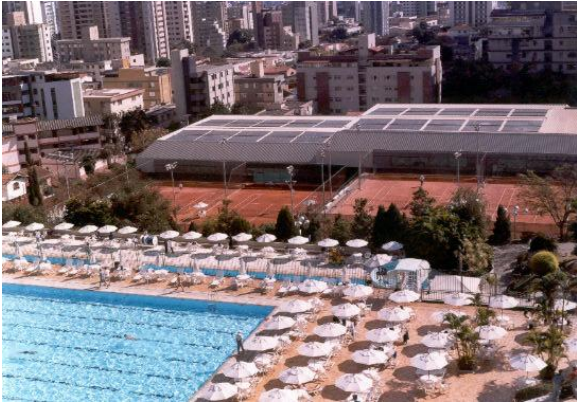
Aquecimento de 5 piscinas com 930 m 2 de coletor solar
